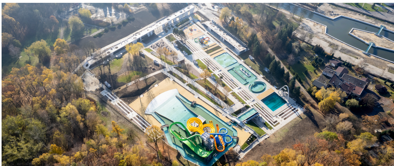
fot. Krzemiński Foto x Mostostal Zabrze GPBP S.A.
